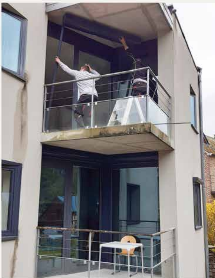
Installation de volets électriques sur toutes les fenêtres.
