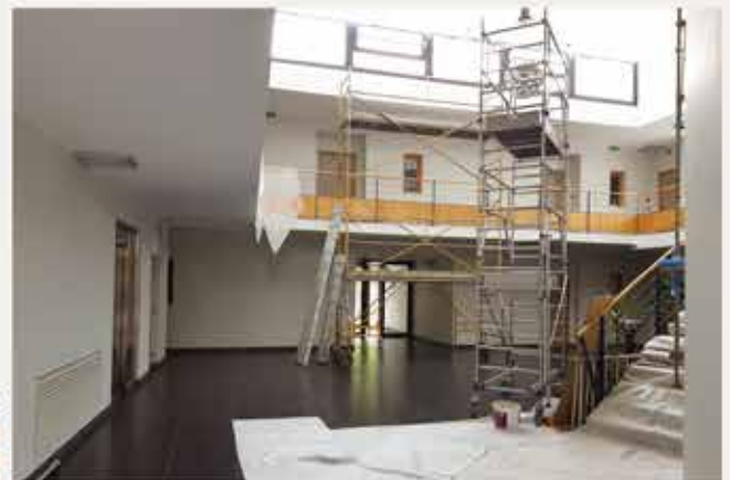
Travaux de peinture
