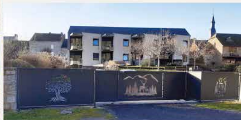
Installation d'un portail électrique au niveau du parking.
